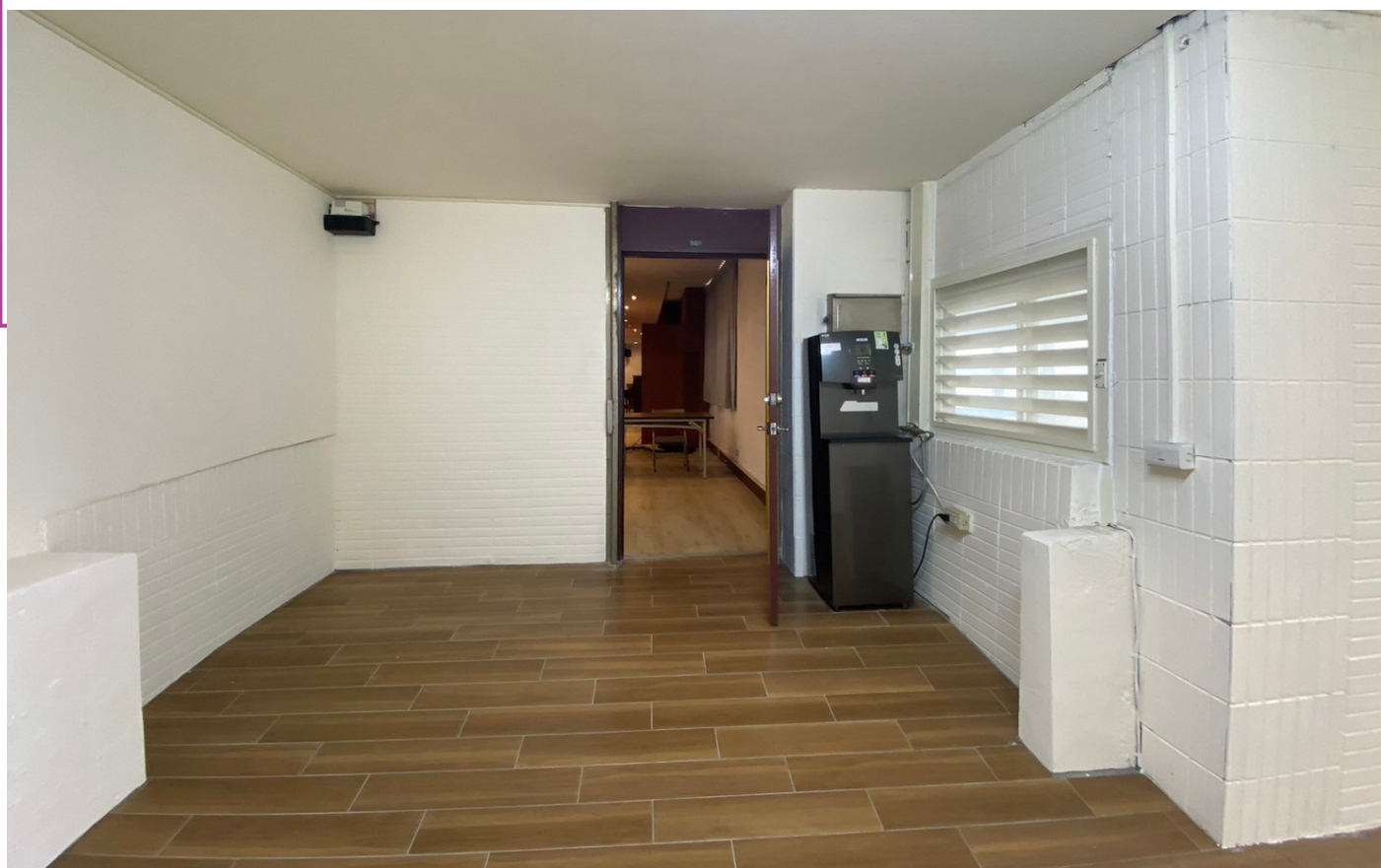
蘊慧樓演藝廳美化工程
